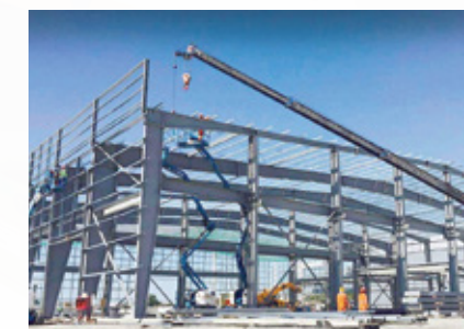
THI CÔNG NHÀ XƯỞNG 工厂建设
